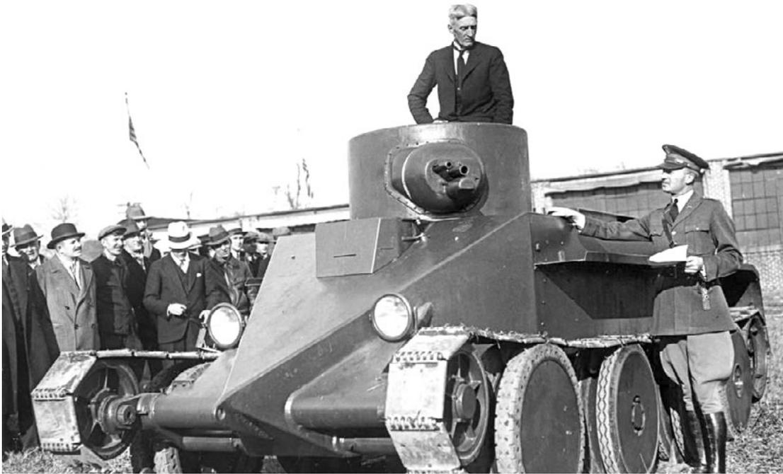
Дж. Кристи демонстрирует американским военным свой колёсно-гусеничный танк Combat Car T.1, построенный на основе экспериментальной модели M1931
